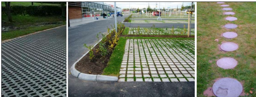
Figur 13. Ytor med hålsten av betong samt gångstig med gräs och gångplattor
