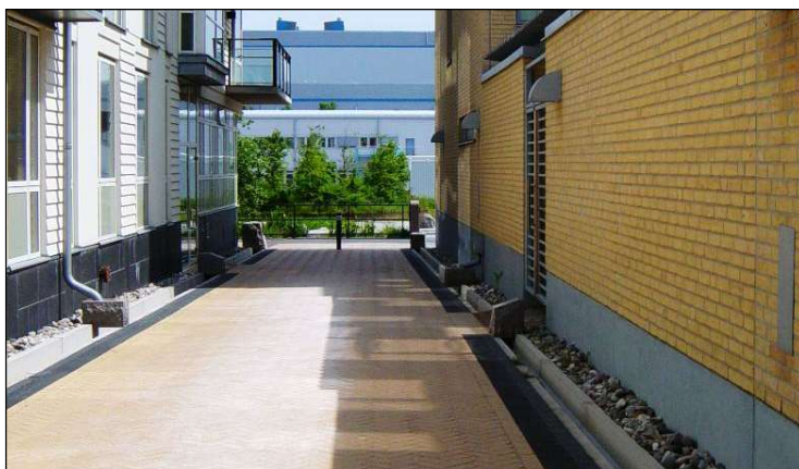
Figur 10. Stuprören ansluter till rännor för avledning av takvatten
