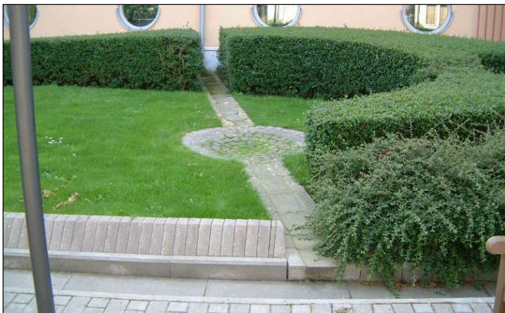
Figur 11. Exempel på ränna för avledning av takvatten
