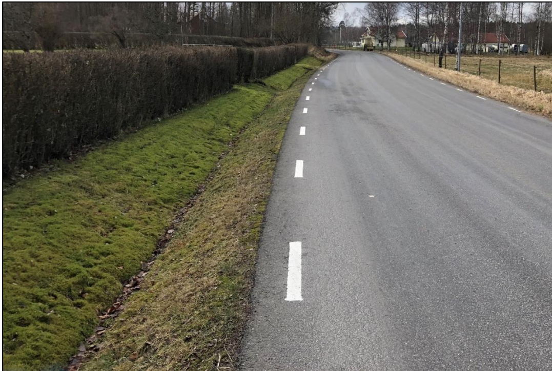
Figur 8. Befintligt dike utmed Gamla Törebodavägen (Foto: Norconsult).
