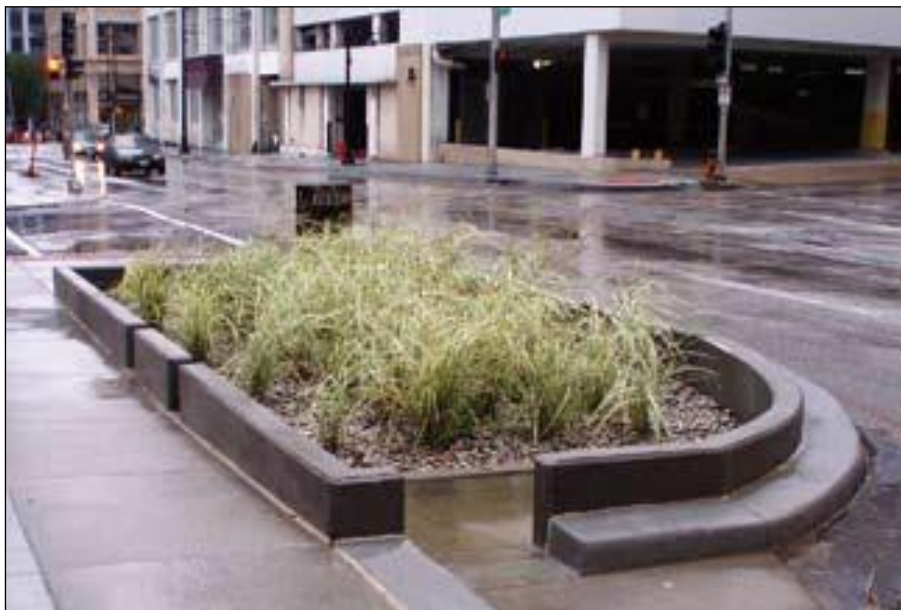
Figur 8. Exempel på regnbädd längs en väg, observera utformning av kantsten (Källa: VegTech)
