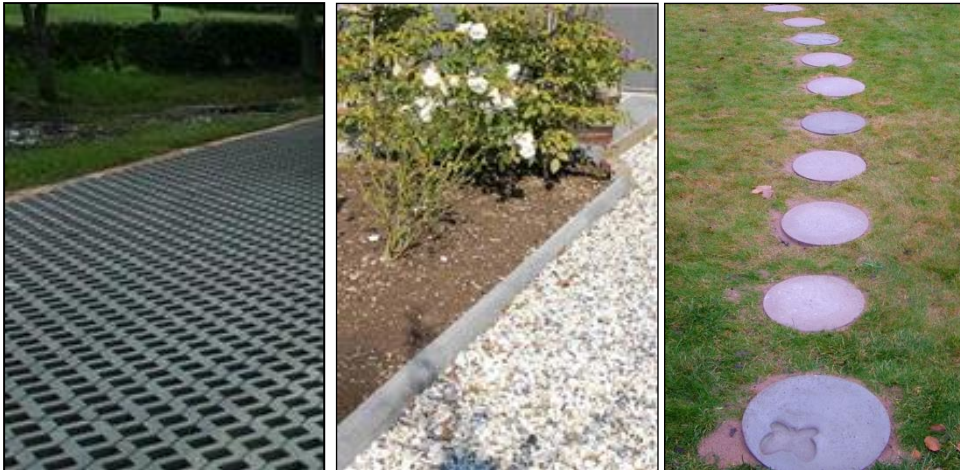
Figur 12. Yta med hålsten av betong, makadambelagd gång, samt gångstig med gräs och några gångplattor i betong (Foto: Norconsult)
