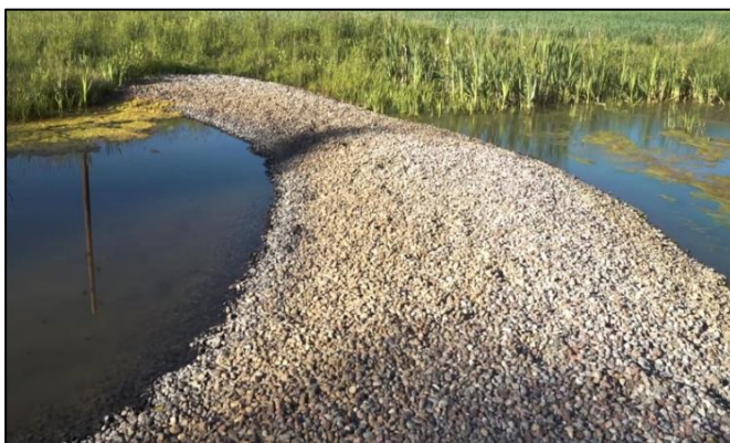
Figur 17. Singelvall kan skilja av ett eventuellt försedimenteringssteg i dammen (Dagvattenguiden, u.d.)
