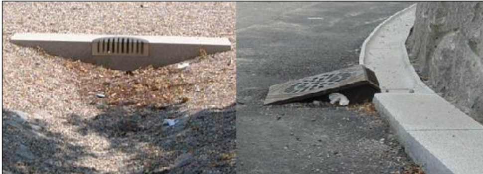
Figur 13. Torr översvämningsyta med modern gallerbrunn, exempel från Norra hamnen, Helsingborg och rännalsplatta med gallerbrunn, exempel från Hammarby Sjöstad, Stockholm (Foto: Emma NK)
