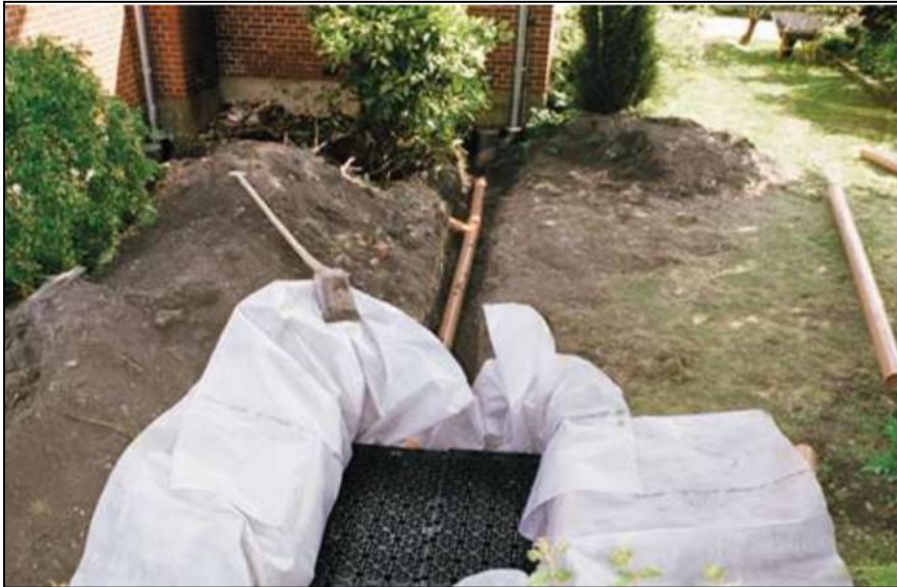
Figur 2. Kassetmagasin för fördröjning av dagvatten (Foto: Wavin)
