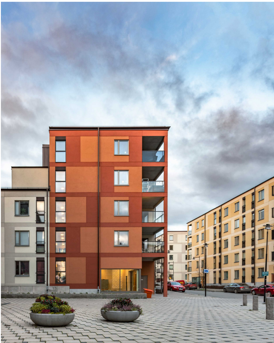
Arken av QPG. Betongelement med fasadfärg med ballast skapar putskaraktär.
