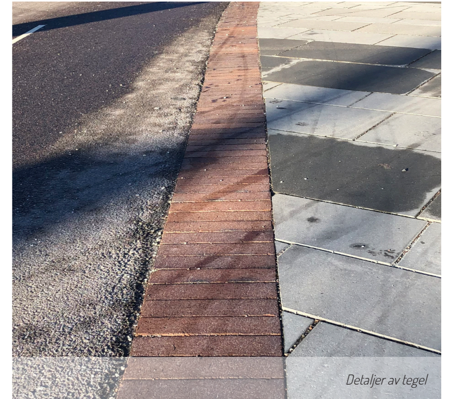
detalj möte mellan betongsten, storgatsein och asfalt
