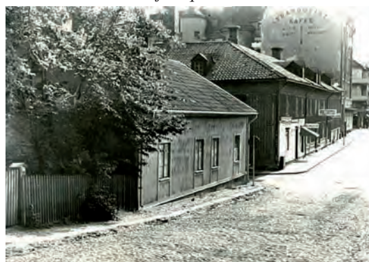
Äldre bostadsbebyggelse i kv. Bryggaren och Målaren vid Lögegatan, riven i övergången 1960-70-tal. Foto: Olle Stjernqvist. VGM.
