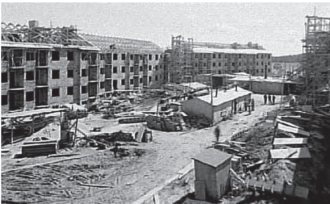
Gasbetongbygge i Lakestan på Östermalm i efterkrigstidens 1940-tal, när Skövde började expandera stort. Ej angiven fotograf. VGM.
