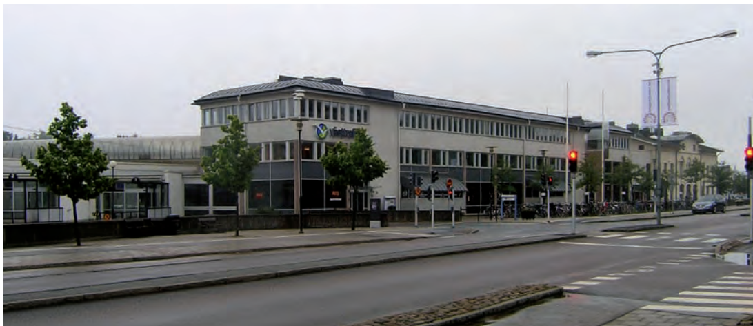
I början av 1990-talet byggdes järnvägsstationen och stationsbyggnaden om till Resecentrum. Det befintliga stationshuset från 1859 (i bildens bortre del), genomgick samtidigt en renovering som i stort anknöt till 1903 års utformning.
