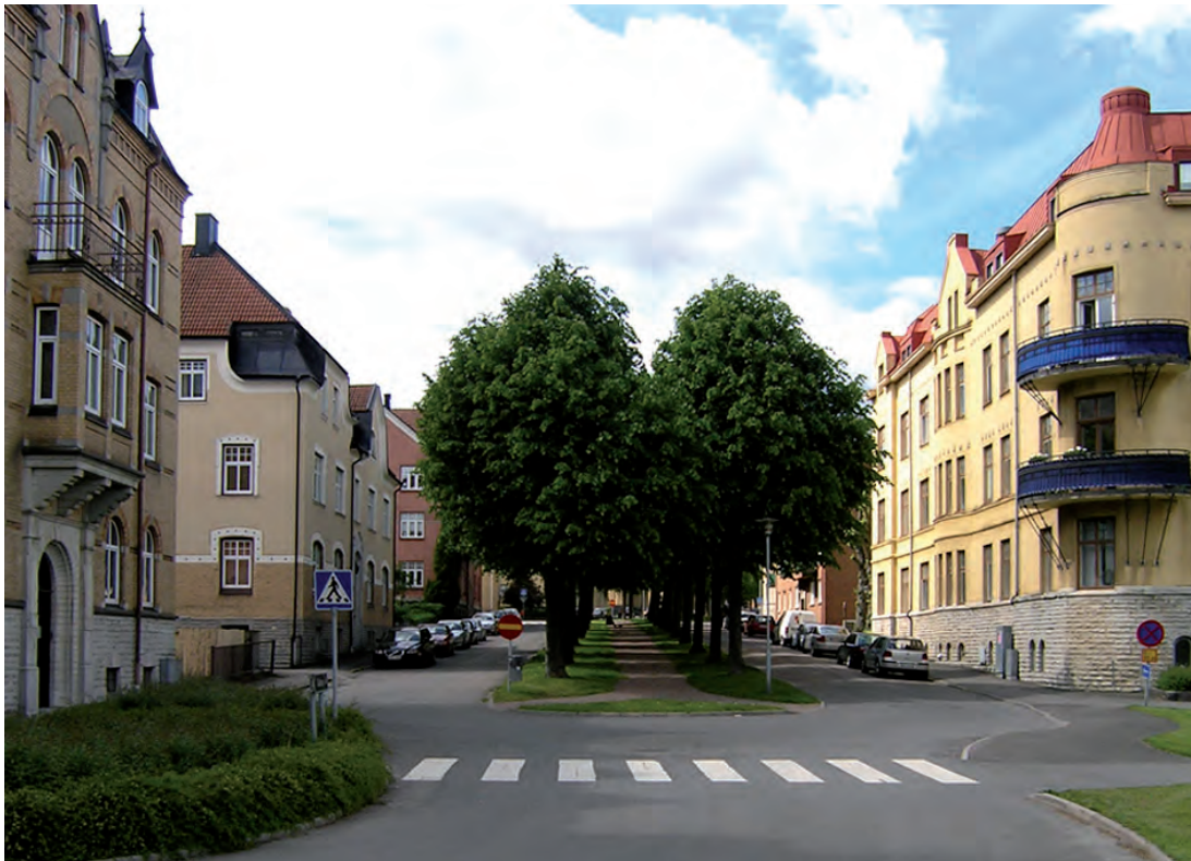
Vasastaden bebyggdes som en tidstypisk borgerlig stenstad från tidigt 1900-tal. Privatvillor och hyreshus utformades efter den tidens rådande arkitekturstilar. Huvudgatan Vasagatan är anlagd som en esplanad med skilda körbanor och trädkantad promenadväg i mitten. Vid Vasaplan.
