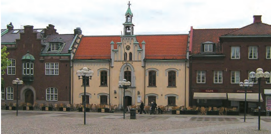
Rådhuset på Heimdal 20 (f.d. 5) vid Hertig Johans torg byggdes 1775-76 och var stadens första stenbyggnad, frånsett kyrkan. Nuvarande exteriör är från 1853 års ombyggnad. Rådhuset omges till vänster av kanslihuset från 1915 och det före detta kommunalhuset från 1934.
