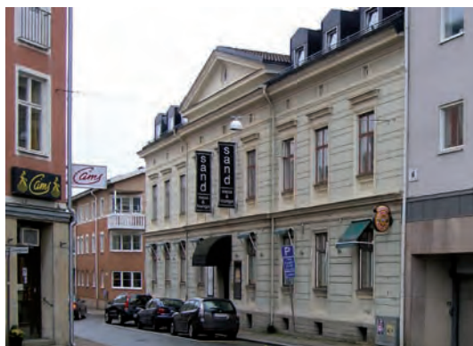
Centrums mest komplett bevarade gårdsmiljö från sent 1800-tal är Höder 3 . Anläggningen tillkom under perioden 1861–1914 men med tonvikt på 1880-talet, bl. a. stora bostadshuset med en rikt utformad putsfasad.
