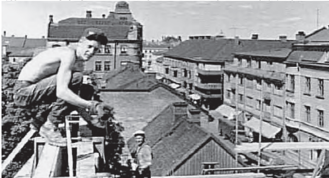
Byggnadsarbeten pågår på hustaket vid Storgatan, eventuellt kring 1960. Fotograf ej angiven. VGM.
