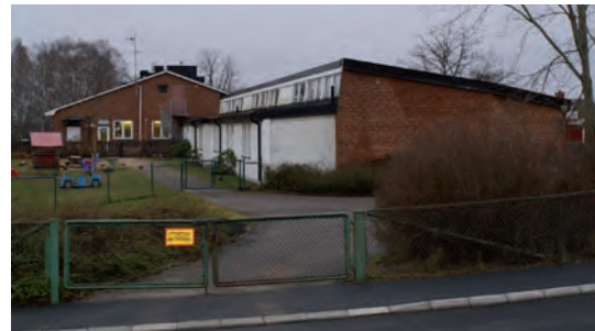
Arkitekt Hans-Erland Heineman utformade 1952-53 den lilla Källegårdsskolan som även idag har kvar sin 1950-talskaraktär. ( Gläntan 3 ).
