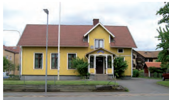
Ovan: Kåpplunda Blåbandsförenings folkrörelselokal byggdes 1909 i kanten av det blivande Norrmalm. Byggnaden är senare ombyggd men genom sitt ursprung ett viktigt minne av industrialismens samhälle. (Skoltuna 14).
