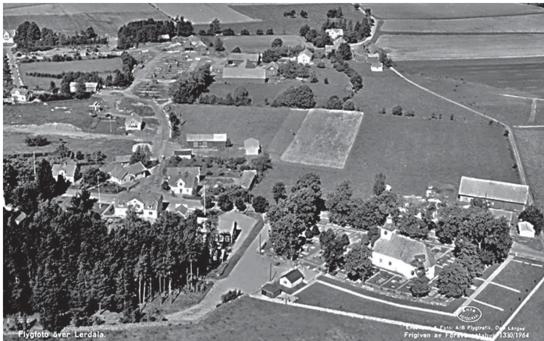
Flygfotot från år 1964 visar Lerdalas centrala del med kyrkomiljön, den f.d. småskolan och Klockaregården i förgrunden, till vänster Fridhem 2, den f.d. handelsboden samt Sethsberg. Vägen till den f.d. järnvägsstationen ringlar ner över sluttningen i bildens vänsterkant. Några gårdar som utskiftades från byn på 1800-talet ligger nere i sluttningen. Jordbruksmark inramar bybebyggelsen. Foto: AB Flygtrafik, Dals-Långed. VGM.
