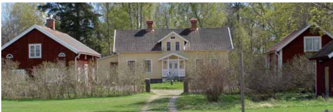
Sventorp 2:2 Östergården är en av byns välbevarade gårdsmiljöer med 1800-talsbyggnader.
