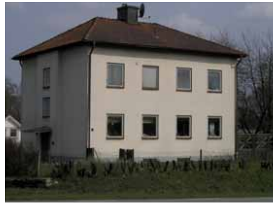
Skultorp 8:72 vid Skövdevägen i är ett bra exempel på hur man i Skultorp på 1930- och 40-talet uppförde flera villor och små flerbostadsvillor med drag av tidens funkisstil med ljusa putsfasader och flacka tegeltäckta tak.
