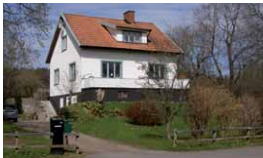
Skultorp 16:10 Bergshamra Villastilen från 1950-talets början är väl bibehållen.
