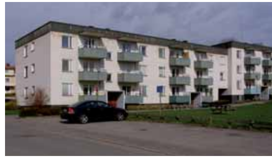
Skultorp 1:207. Pilvägens flerbostadskvarter nära Norra Kyrketoprns kyrka färdigställdes 1969. Området har en karaktäristisk utformning typisk för den tiden med lamellhusens flacka tak och ljusa mexistensfasader.
