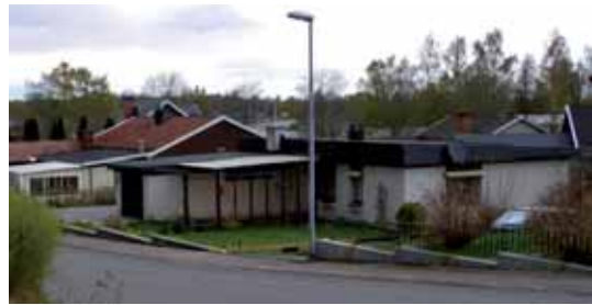
Hene 18:27 byggdes från början 1956 med silitstomme vilket gör huset teknikhistoriskt intressant. Det byggdes senare om utvändigt 1967 eller 1973 till nuvarande utseende.
