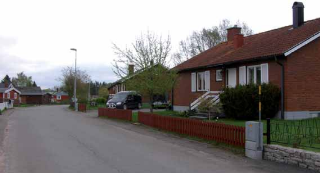
Brunnsvägens enplansvillor med källare och röd tegelfasad byggdes vid 1960-talets mitt.
