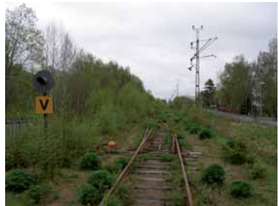
Råls, ledningsstolpar och lastkaj mm vittnar om stationsamhället Igelstorps ursprung.
