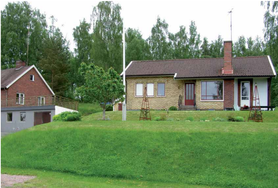
Nedan: Lerdata 2:61 (till höger i bilden) har en mer detaljerad arkitektonisk utformning än områdets övriga villor. 1950-talets modernistiska villastil är mycket väl bibehållen. Till vänster syns en av kulturmiljöns fåtaliga villor i rött tegel.
