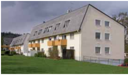
Hene 18:65. Riksbyggenvägens lamellhus från 1958-1960 med sina ljusa putsfasader och karaktäristiska asymmetriska sadeltak var det första större flerbostadsområdet i Skultorp och inledde den moderna tätortens uppbyggnad.
