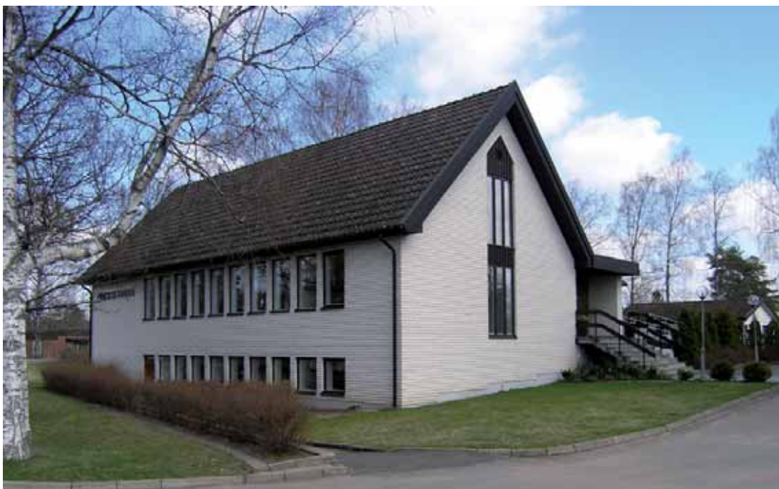
Stångesäter 4:6 Pingstkyrkan Bygglöv utfärdades 1976 för en ny mycket tidstypisk kyrkobyggnad i anslutning till ett befintligt bostadshus. Pingstkyrkan har en stark lokalhistorisk förankring i Stöpen.
