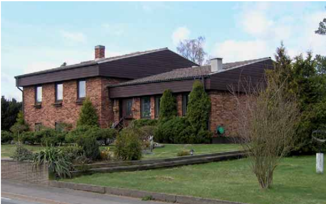
Frösve 3:46. Villan byggdes 1976 i en mer påkostad villastil med fasad i flamrött tegel och mörkbrun panel på takfotssarg och i gavelrösten.
