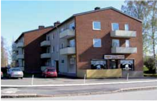
Skulptorp 35:1 byggdes 1961 och är ett gott exempel på den tidens flerbostadshus med affärslokaler i bottenvåningen.
