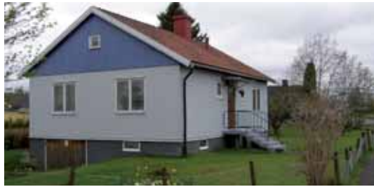
Sventorp 4:26. Bostadshus från 1962, ett mycket gott och välbevarat exempel på en hustyp som producerades av AB Elementhus i Mockfjärd.
