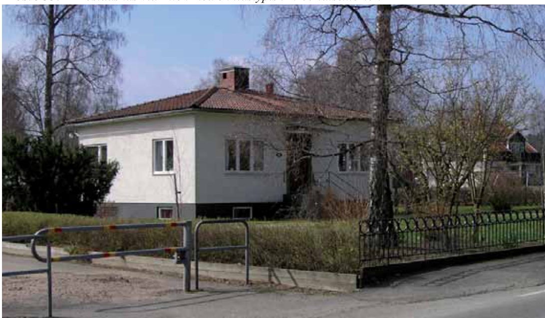
Frösve 33:12 Bostadshus vid Allén med en tidstypisk 1940-talsexteriör.
