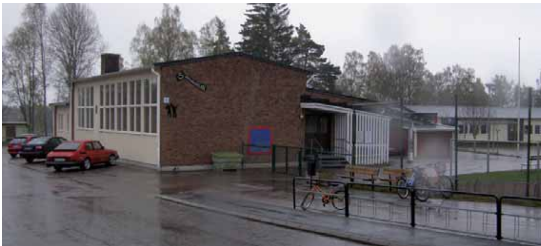
Skultorp 1:234 Svärtagårdsskolan är i sin kärna en väl bibehållen 1960-talsanläggning.
