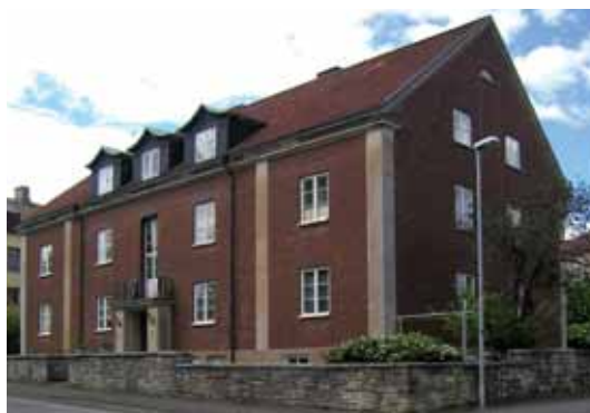
Lärkträdet 4 med välbevarad exteriör i 1920-talsklassicism från 1929 är ett av de första hus i Skövde som byggs med stomme av gasbetong.
