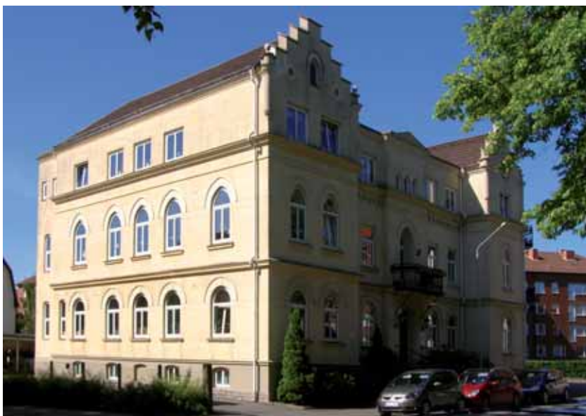
Castor 6, Villagatan 7. Flerbostadshus uppfört 1904 efter ritningar av arkitekt Frans Adolf Wahlström åt handlanden J.G. Karlberg. Huset innehöll ursprungligen fem större lägenheter, bl.a. en lägenhet om sju rum, kök och andra biutrymmen som upptog ett helt våningsplan.
