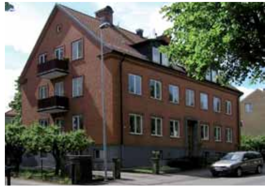
Kamelen 1 Vasagatan 19/Karlskatan 7 är ett litet flerbostadshus i rött tegel med välbevarad prägel av 1930-40-tal med många ursprungliga detaljer.
