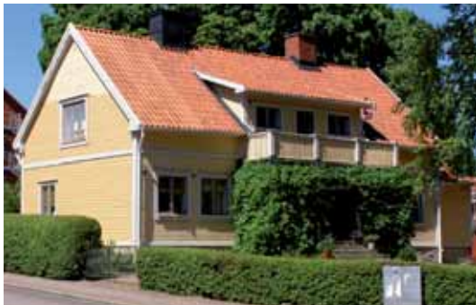
Häggen 23, Skolgatan 20/Richerts gata 8. Kommunistergården är ursprungligen från ca 1825, alltså ett av Skövdes äldsta hus idag. Nuvarande exteriör präglas av en ombyggnad 1923, en karaktär som är välbevarad.
