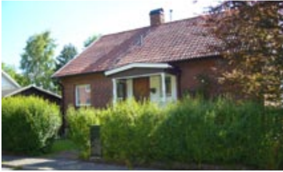
Glader 9 Lingonstigen 18 Småhus, 5 rok, 1,5-plan + källare 1963 Skaraborgs Byggtjänst AB, Skövde Byggherre: Rune Larsson Ändringar: 1998 Installation av braskamin, 2002 Tillbyggnad garage, förråd, _____ Skorstenskupa, Ändrad entré, Uthus
