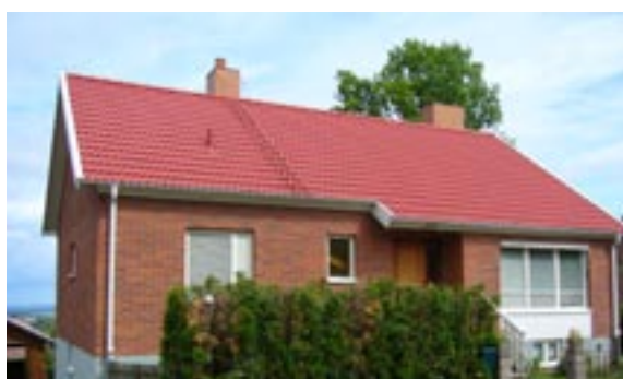
Butter 3 Lingonstigen 77 Enfamiljshus, 3 rok + källare 1961 Olofsson, Andersson Arkitektkontor, Skövde Byggherre: Knut Sjögren Ändringar: 1964 Förvaring av brandfarlig vara, 1985 Takkupa, 1992 Carport, ____ Garage, Nytt tak betongpannor, Tillbyggnad
