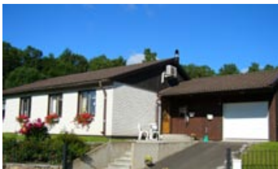
Glader 1 Lingonstigen 2 Småhus, 4 rok, garage i markplan 1958 AB Svenska Trähus, Stockholm Byggherre: Ä Måård Ändringar: 1959 För låg skorstenshöjd, 1960 Stenmur, 1964 Förvaring av brandfarlig vara, 1984 Tilläggsisolering och ny fasadbeklädnad, 1998 Tillbyggnad, 2006 Pannbyte, ____ Inklädd skorsten, Nytt tak äldre betongpannor
