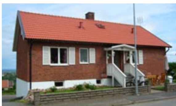
Butter 5 Lingonstigen 73 Enfamiljshus, 6 rok, 1,5-plan + källare 1963 AB Fogelfors bruk Byggherre: P Lindh Ändringar: 1971 Upptagning av front på vindsvåningen (takkupa), ____ Ändrad entré, Nytt tak betongpannor, Förmodligen ej ursprunglig sockelfärg
