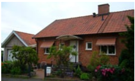
Kakan 1 Blåbärsstigen 57 Enfamiljshus, 3 rok + källare 1957 AB ____ hus Byggherre: Helge Fredriksson Ändringar: 1958 Staket, 1966 Förvaring av brandfarlig vara, 1992 Garage, Vindskupa, ____ Inglasad altan
