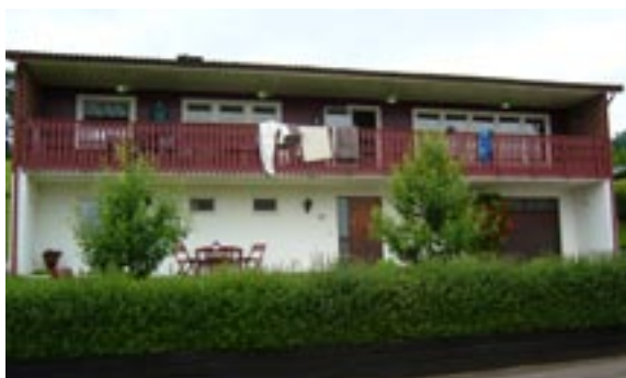
Bullen 7 Blåbärsstigen 17 Enfamiljshus, 7 rok varav 2 suterräng 1969 AB Götene Träindustri Byggherre: Lennart Johansson Ändringar: ____ Uterum
