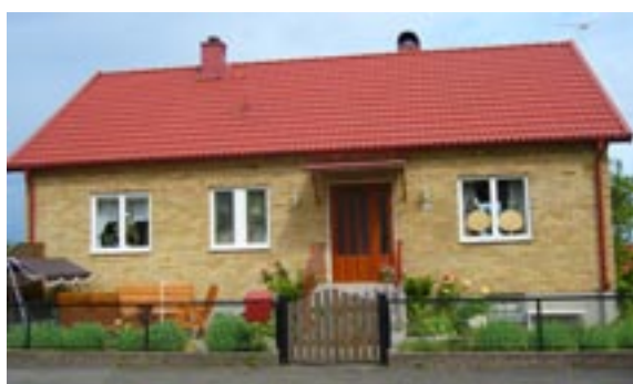
Butter 4 Lingonstigen 75 Enfamiljshus, 3 rok + källare 1958 Olofsson, Andersson Arkitektkontor, Skövde Byggherre: A Larsson Ändringar: ____ Nytt tak betongpannor, Skorstenkupa, Uthus
