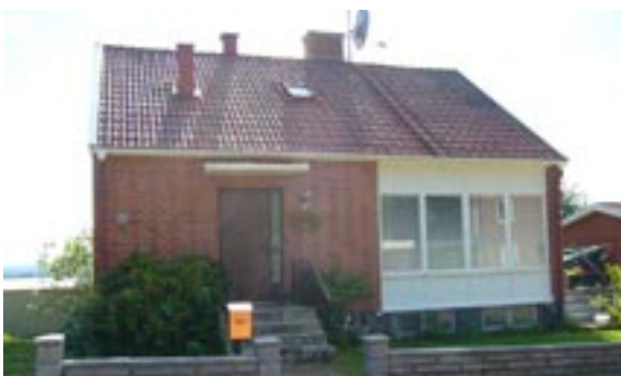
Glader 12 Lingonstigen 24 Småhus, 5 rok, 1,5-plan + källare 1961 O H Olofsson Arkitektkontor, Skövde Byggherre: Gösta Ekström Ändringar: 1964 Förvaring av brandfarlig vara, 1974 Inredning av vind, _____ Uthus
