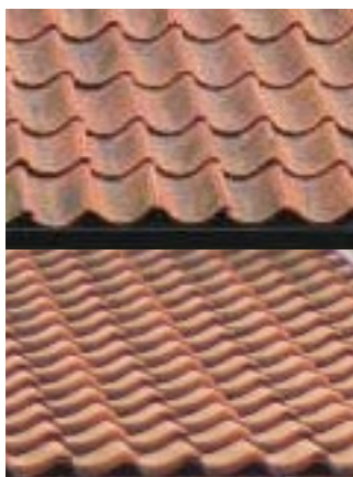
Överst ett tak av lertegel. Under ett tak med röda betongpannor. Lerteglet är tunnare än betongpannorna.
