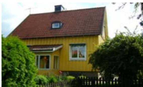
Källegården 3 Åkervägen 9 Enfamiljshus, 6 rok, 1,5-plan + källare 1954 AB Standardhus, Hultsfred Byggherre: Åke Kruus Ändringar: 1964 Garage Valter Andersson Arkitektkontor, 1981 Förråd samt fasadbeklädnad Anne-Britt Andersson, ____ Inklädd skorsten, Tilläggsisolering, Inglasad entréaltan
