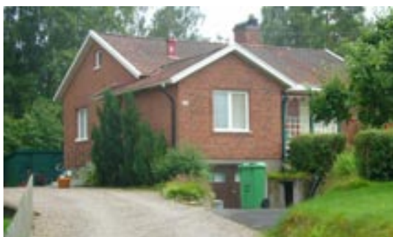
Gärdsgården 5 Hentorpsvägen 35 Enfamiljshus, 4 rok + källare 1954 AB Svenska Trähus, Stockholm Byggherre: E Nordenskär Ändringar: ____ Skorstenskupa
