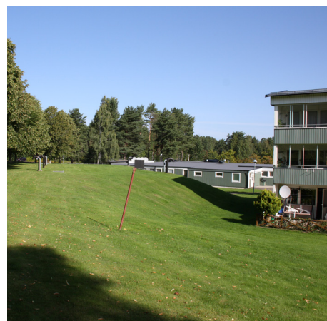
Ett av skyddsrummen norr om planområdet.
