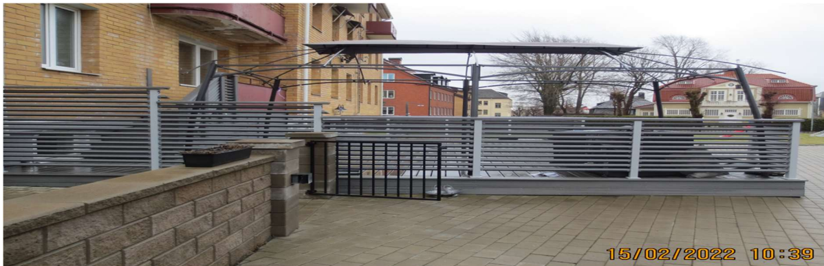
Plank vid uteplats har tillskapats. Totalt 20 meter av höjd om 1,1 - 1,6 meter från altangolv.
