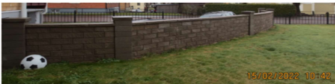
16 meter lång och 1,4 m hög mur har uppförts.
