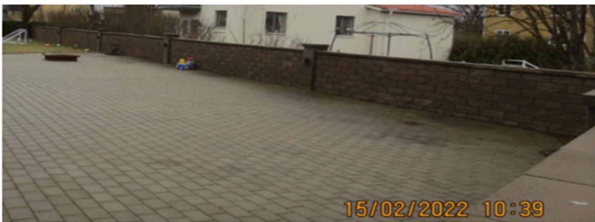
35 meter lång och 1,1 - 1,2 meter hög mur har uppförts.
