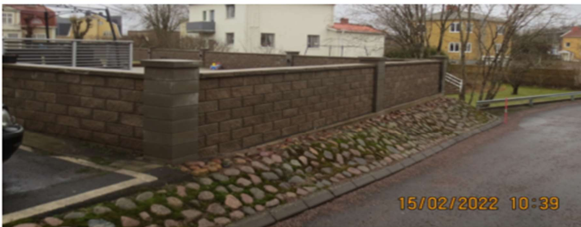
10 meter lång och 1,1 - 1,2 meter hög mur har uppförts.
