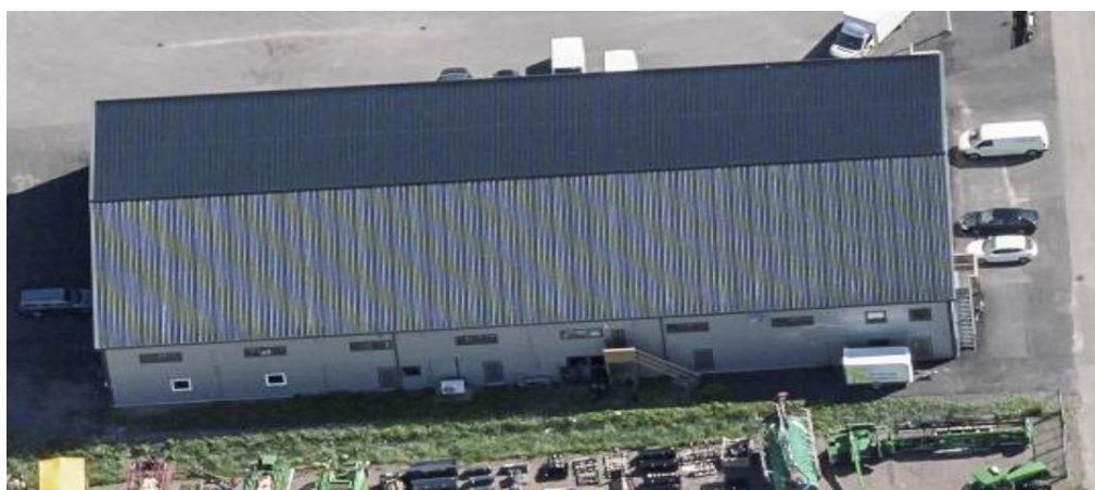
Foto Byggnad 2 fasad mot väster 2019-05-31
