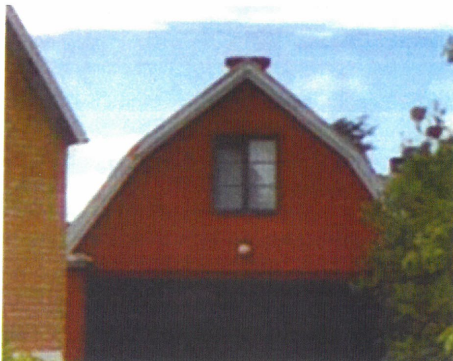
Bild 4- fasad mot öster - Google Maps 2009
