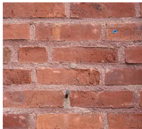
Rött tegel från Börringe, murat med rödinfärgat bruk. Bild från antikvariskt utlåtande.
