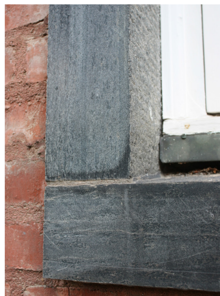
Exempel på naturstensdetalj, diabasen i tingshusets fönsteromfattningar. Bild från antikvariskt utlåtande.
