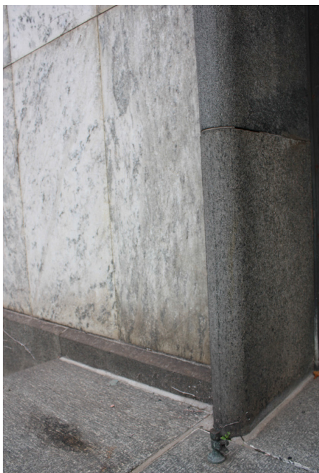
Exempel på naturstensdetaljer, mötet mellan sockelns gnejs, dörromfattningens diabas och portalens släta marmor. Bild från antikvariskt utlåtande.
