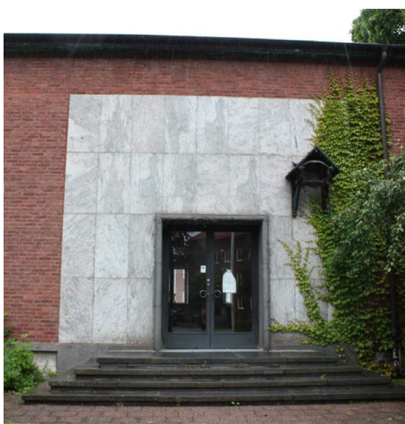
Tingshussalens huvudentré med sin naturstenstrappa. Ingången markeras med en stram portal av ljusa marmorplattor. Omfattningen är av slipad diabas. Bild från antikvariskt utlåtande.
