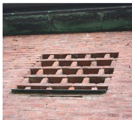
Mönstermurat gallerverk på Tingshuset, ett exempel på den höga hantverksskickligheten. Bild från antikvariskt utlåtande.
