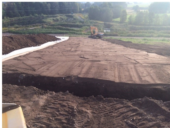
Skyddande material under det blivande tätskiktet på Risängen i Skövde
