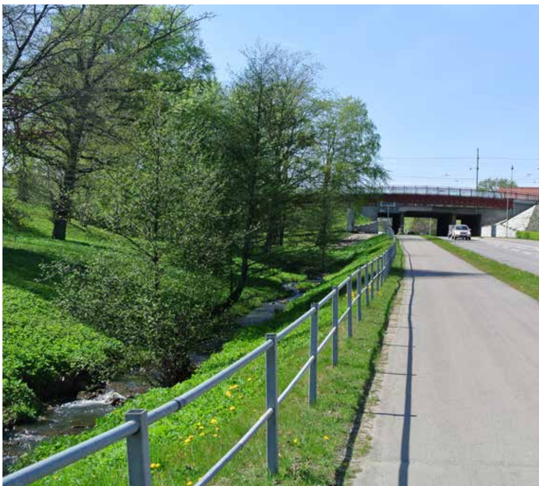
I Mörkebäcken utmed Hjovägen ansamlas dagvattnet från centrumområdet.
