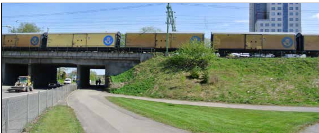
Närmiljön kring porten under järnvägen vid Mörkekorset är till synes helt ogestaltad.
