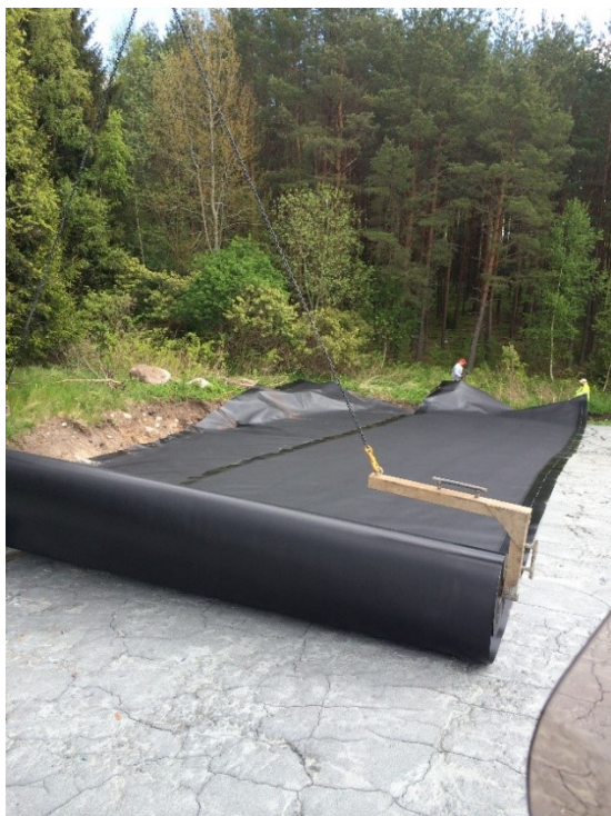
Utrullning av tätskikt (geomembran) i Karlsborg
