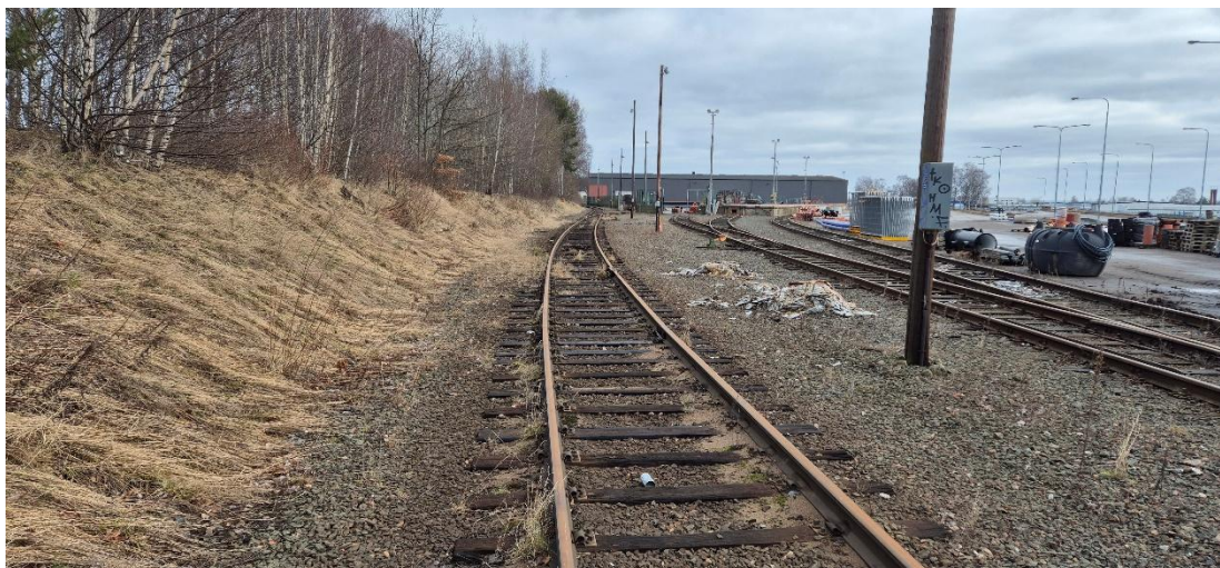
Foto 3. Planområdets nordvästra del med uppställningsspår. Banvallen för nedlagda Karlsborgsbanan syns till vänster i bilden. I bakgrunden skymtar en godsterminalbyggnad. Foto taget mot öster.
