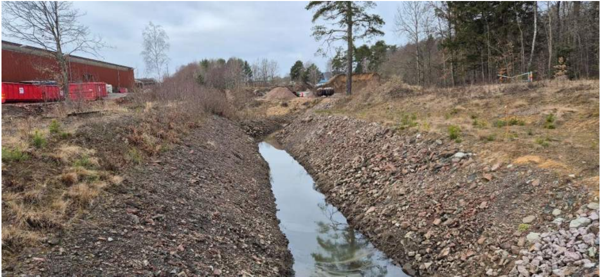
Foto 7. Dagvattendike i planområdets östra del. Foto taget mot väster.
