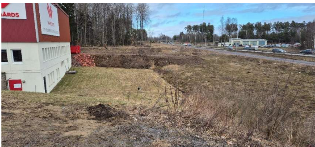
Foto 4. Planområdets östra del närmast riksväg 26 (Östra leden), till höger i bild. Det nedanför plan området i bilden avses att fyllas upp till nivå ca +130 och byggnaden rivas. En uppfyllnad av en kulle till nivå +133 avses att utföras i den nordöstra delen av det uppfyllda området. Foto taget mot norr.
