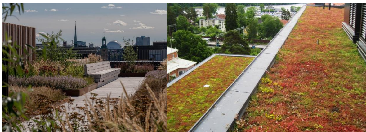
Figur 45. Olika typer av utformning av gröna tak, t.v. möjlighet till takterass/gröna tak vid byggnad som klarar högre laster, större kapacitet för fördröjning. T.h. sedumtak lämpar sig som bäst där man inte har samma möjlighet till större laster. (Källa, T.v. Vasakronan 2025 t.h. Takexperten 2025)
