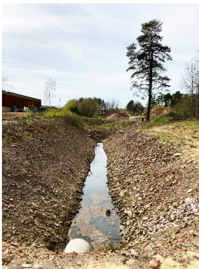
Befintligt dagvattendike i nordost.
