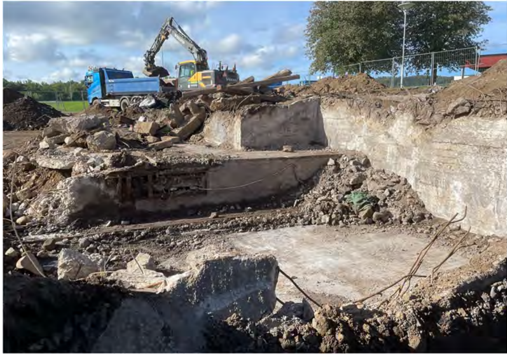
Figur 1. Betonggrund som påträffades under markytan i samband med schaktning inom området.
