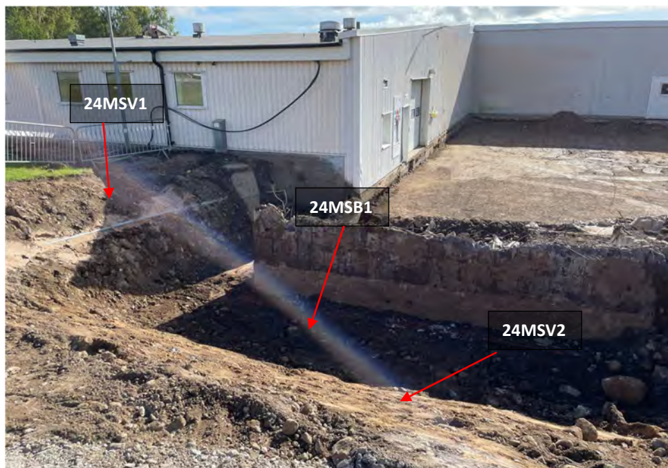
Figur 2. Foto taget 2024-09-13 på de nordvästra schaktväggarna 24MSV1 och 24MSV2 och del av schaktbotten 24MSB1.
