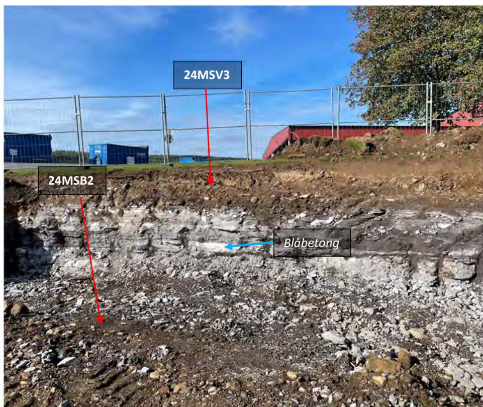
Figur 3. Foto taget 2024-09-26 på den sydvästra schaktväggen 24MSV3 och del av schaktbotten 24MSB2. Provtagning kunde endast utföras i den övre delen av schaktväggen med anledning av blåbetong i nedre delen (se blå pil).
