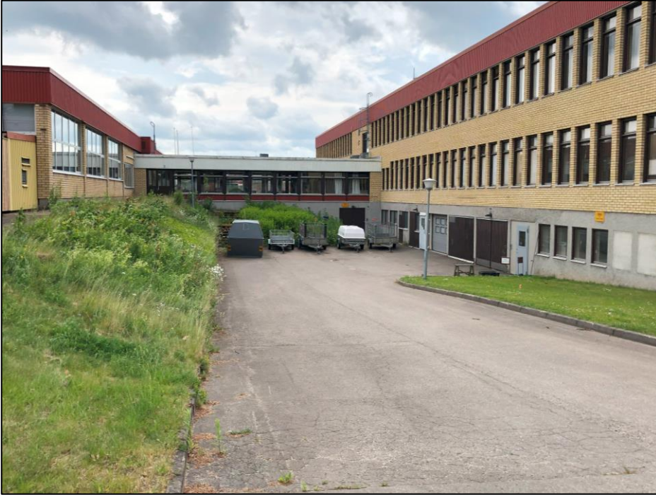
Figur 12. Foto taget på den norra översvämningspunkten.
