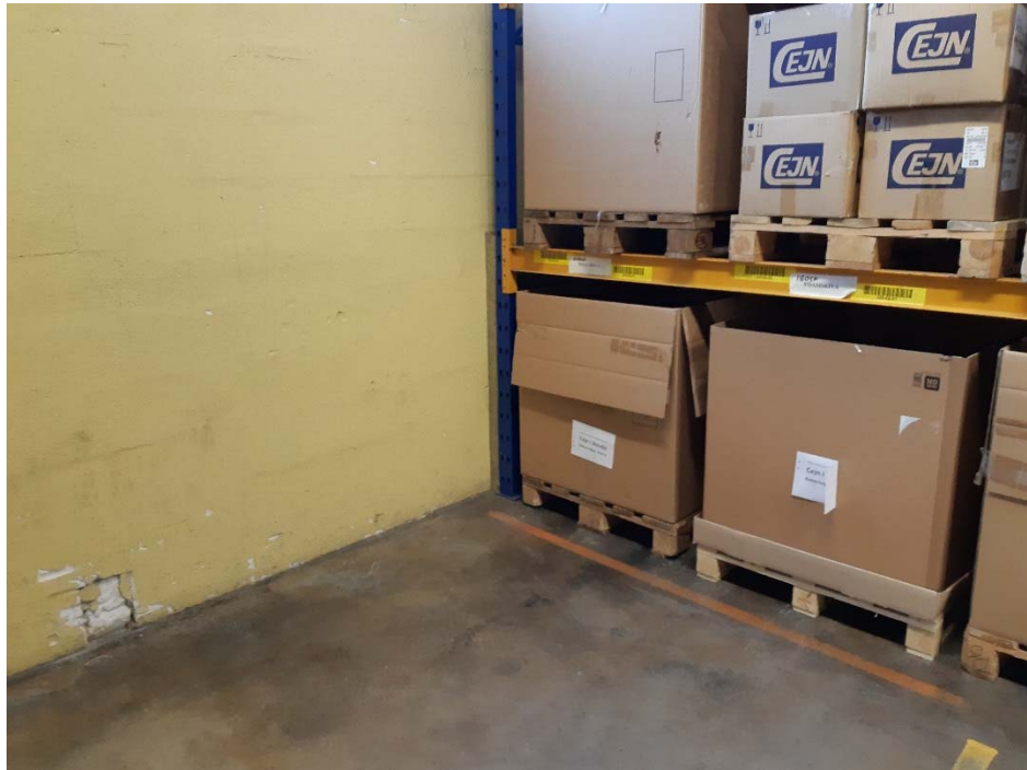
Figur 10. Industrilokal där tritvätt tidigare fanns.
