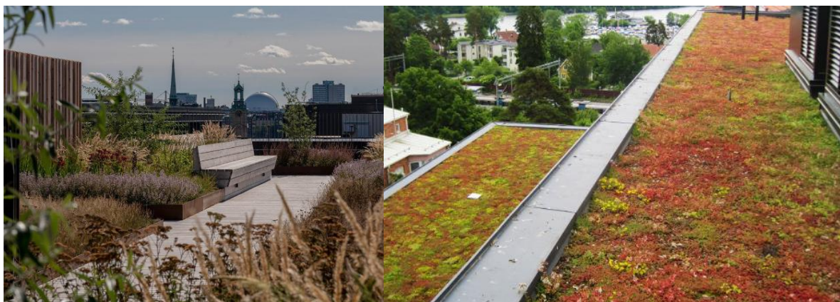
Figur 22. Olika typer av utformning av gröna tak, t.v. möjlighet till takterass/gröna tak vid byggnad som klarar högre laster, större kapacitet för fördröjning. T.h. sedumtak lämpar sig som bäst där man inte har samma möjlighet till större laster. (Källa, T.v. Vasakronan 2025 t.h. Takexperten 2025)
