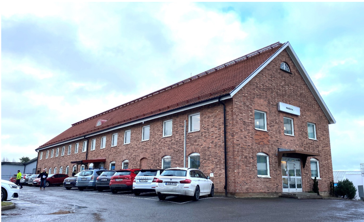
Figur 14. Taket är täckt med tvåkupigt lertegel, fasaderna består av handslaget tegel.
