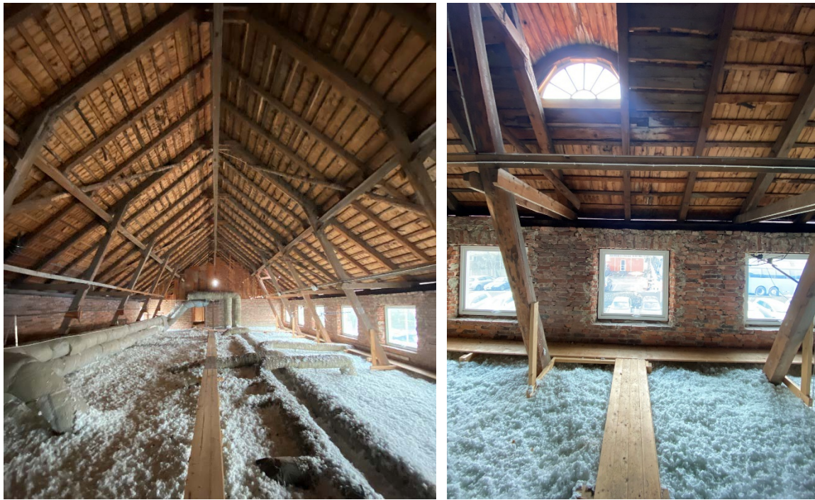
Figur 20. Vindsvåningen har på många sätt en ursprunglig karaktär. Takstolar, undertaket och lunettfönster bedöms som ursprungliga. Både fönsteröppningar och fönstren är sentida, så även isoleringen som täcker hela golvbjälklaget.
