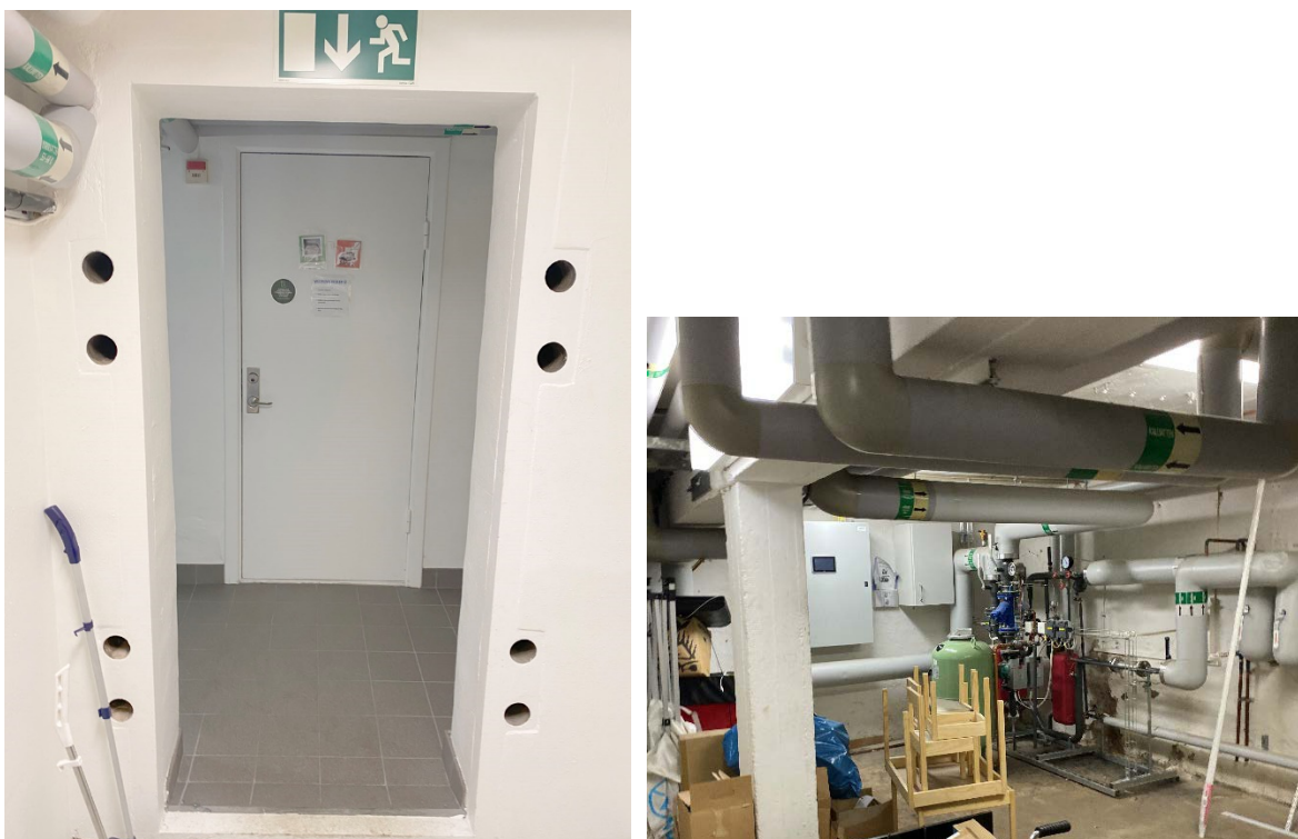
Figur 17. Foton från byggnadens källarvåning, till vänster syns ett f.d. skyddsrum och till höger ett teknikutrymme.
