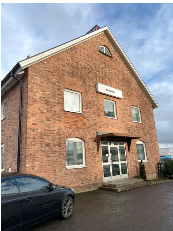
Figur 15. Byggnadens fönster är i huvudsak aluminiumtäckta vippfönster, ej anpassade till de ursprungliga fönsteröppningarna. I vindsvåningen återfinns spröjsade originalfönster i lunettform.
