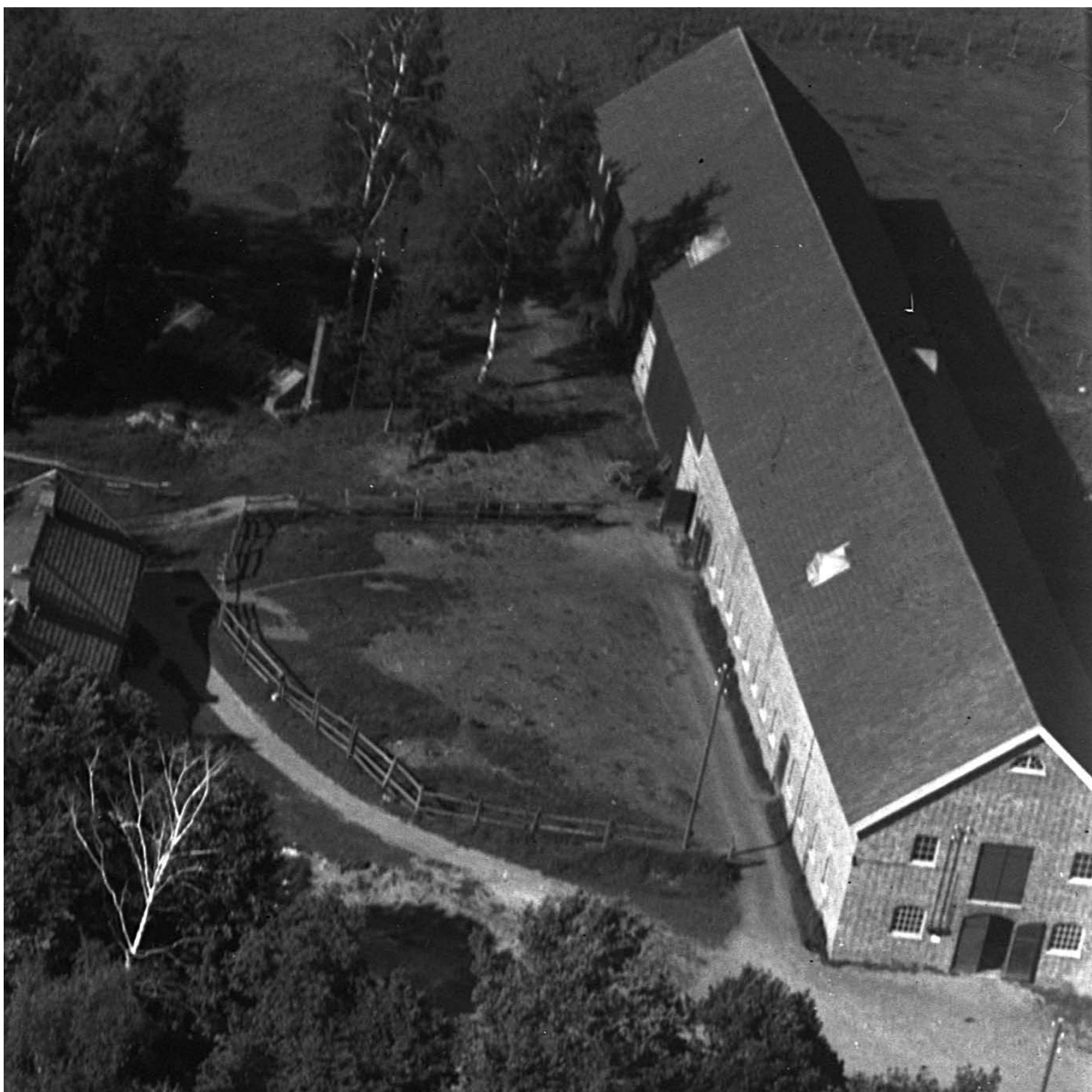
Figur 23. Ladugårdsbyggnaden i närbild från flygfotot från 1938. Här syns fönstrens småspröjsindelning, dörrarnas enkla utförande och vindsvåningens avsaknad av fönster tydligt. Foto från Västergötlands museums bildarkiv.
