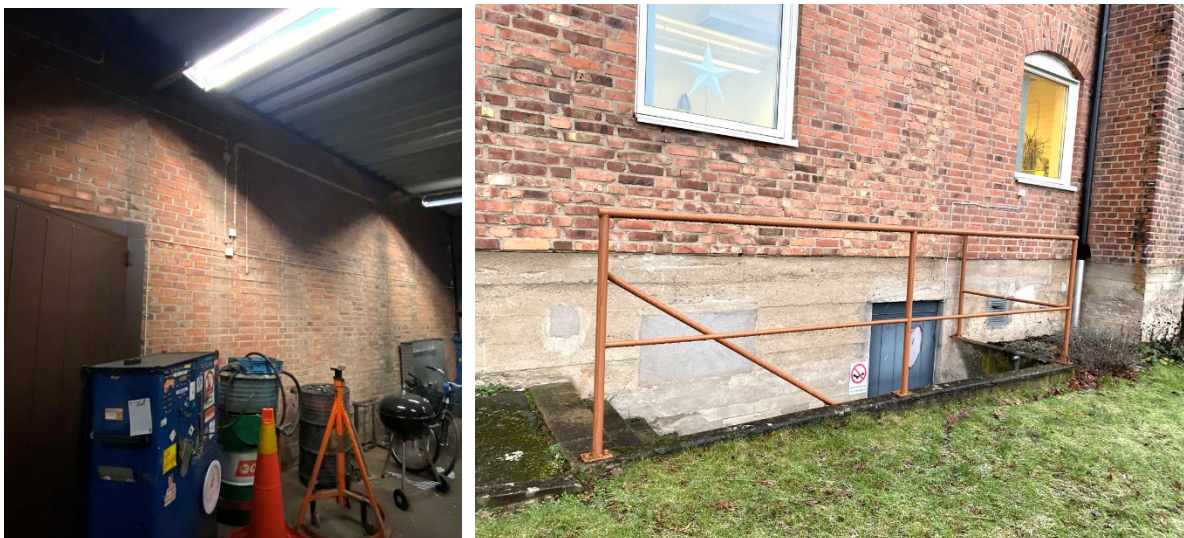
Figur 16. Byggnadens norra gavel är uppförd delvis med modernt tegel efter ombyggnaden 1983. Den del av byggnaden som försetts med källarvåning har en grund av platsgjuten betong
