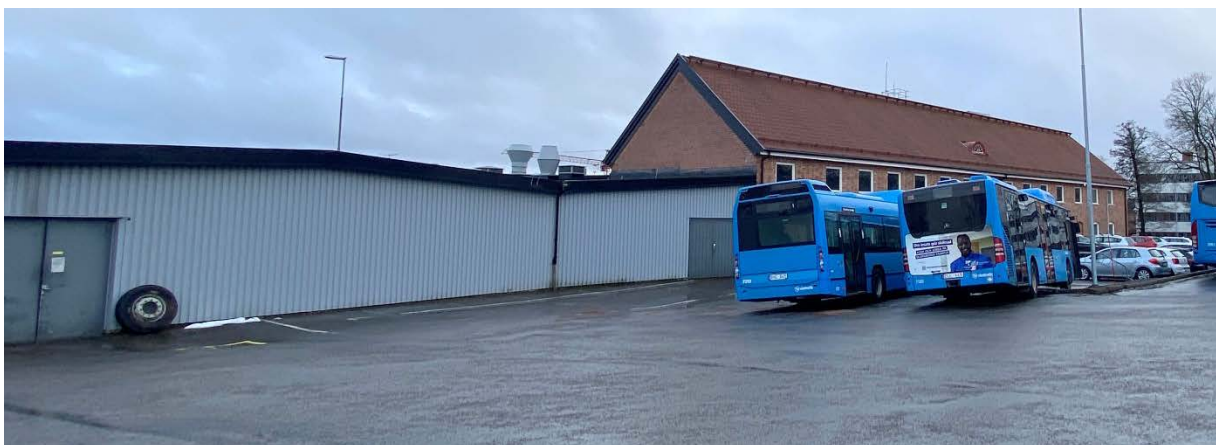
Figur 22. Kallförrådet som är tillbyggt mot byggnadens norra gavel har ett enkelt formspråk, som en sentida industribyggnad. Fasaderna är täckta med korrugerad plåt. Här syns även ladugårdsbyggnadens norra gavelparti som murats upp med modernt tegel.
