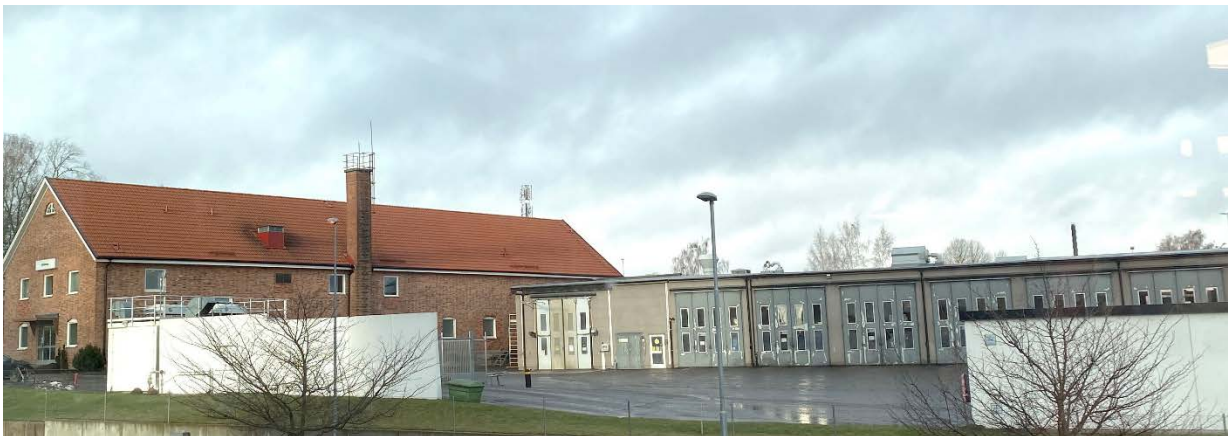
Figur 21. Depåbyggnaden är synlig till höger i bild. Fasaden täcks av flertalet vikkörrar som är av industrikaraktär.
