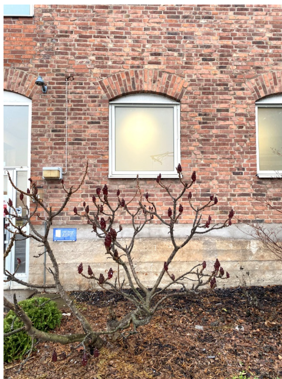
Figur 15. Byggnadens fönster är i huvudsak aluminiumtäckta vippfönster, ej anpassade till de ursprungliga fönsteröppningarna. I vindsvåningen återfinns spröjsade originalfönster i lunettform.
