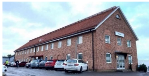
Bild mot nordöst från år 2023. Taket är täckt med tvåkupigts lertegel, fasaderna består av handslaget tegel. Byggnadens fönster är i huvudsak aluminiumtäckta vippfönster, ej anpassade till de ursprungliga fönsteröppningarna. I vindsvåningen återfinns spröjsade originalfönster i lunettform.
