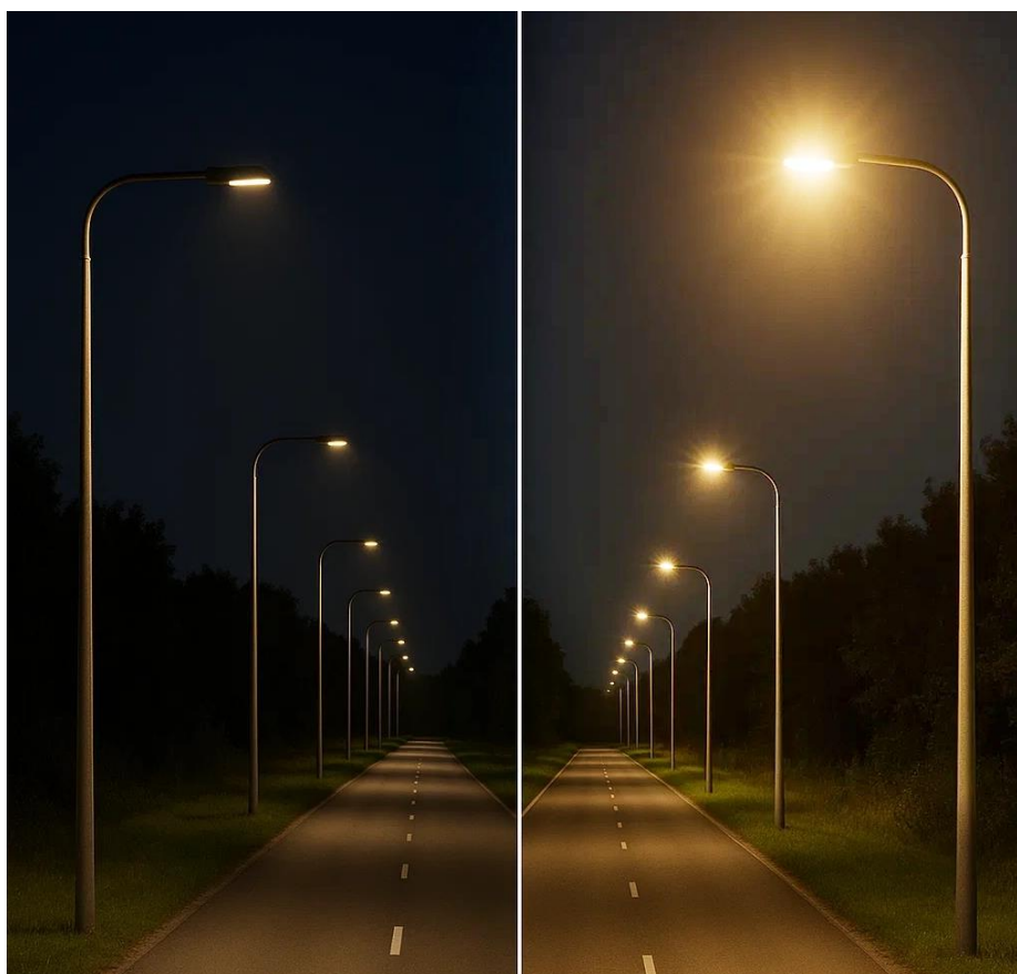
Figur 12 Figur 10 bild t.v. bra exempel på gatuarmatur. En väl avskärmad armatur utan uppljus. Bild t.h. dåligt exempel på gatuarmatur. En dåligt avskärmad armatur som bländar och avger mycket ljus uppåt och i höga vinklar nära horisontalplanet.
