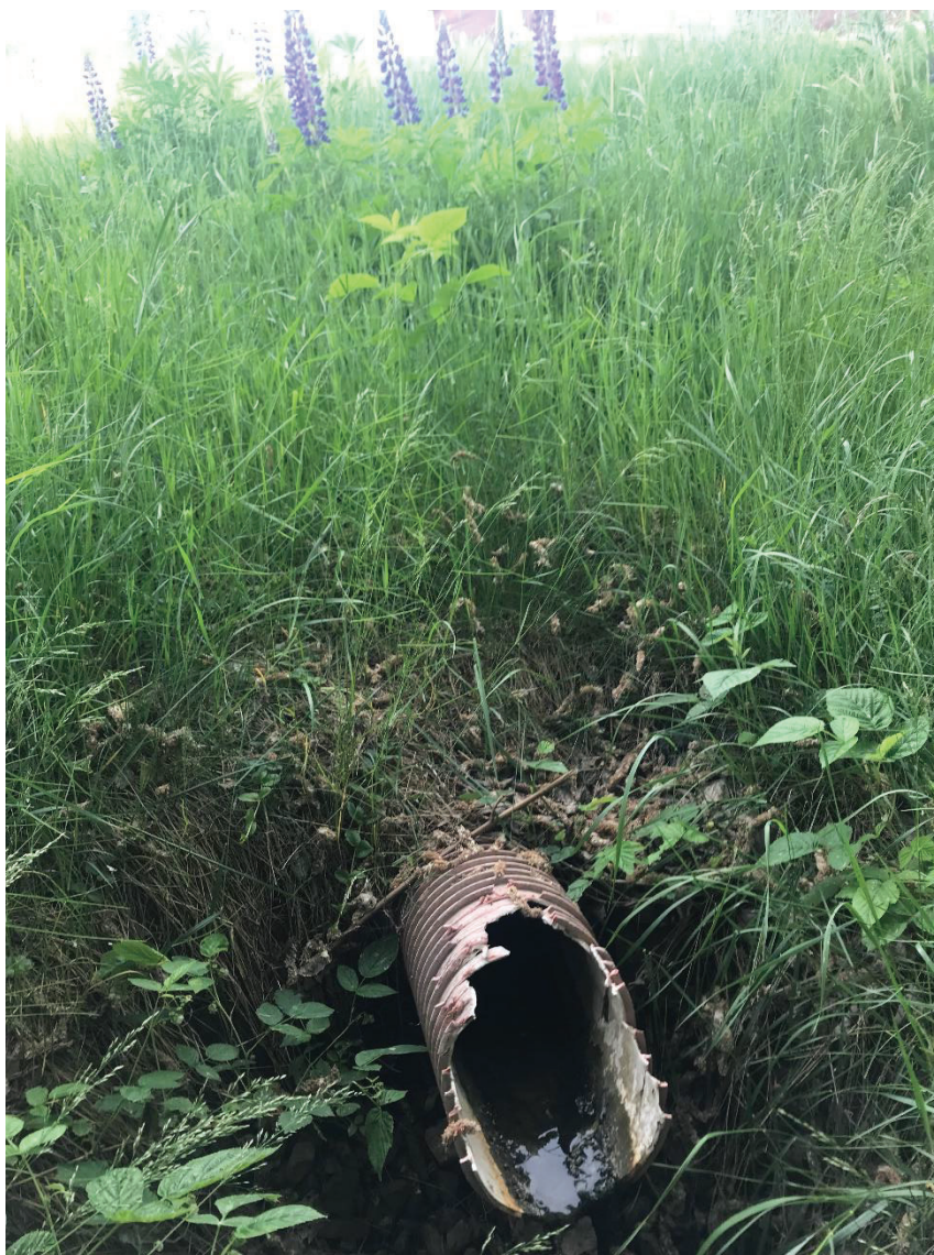
Figur 15. Bild 9. Utlopp från rör som ansluter ett antal villor väster om Lerdalavägen. Dimensionen bedöms vara 160 mm.
