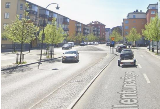
Figur 4-4 Bild på överkörningsbar mittrefug - Bild från Google (Sollentunavägen - Sollentuna)
