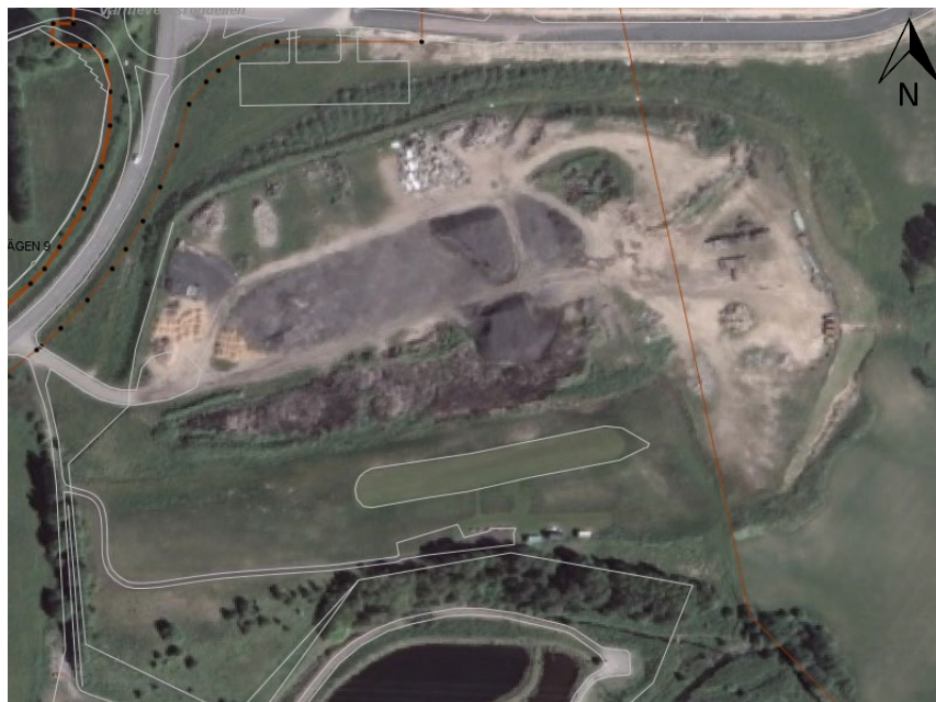
Figur 10. Flygfoto från 2007 16 . Pågående avslutningsarbete på deponin.
