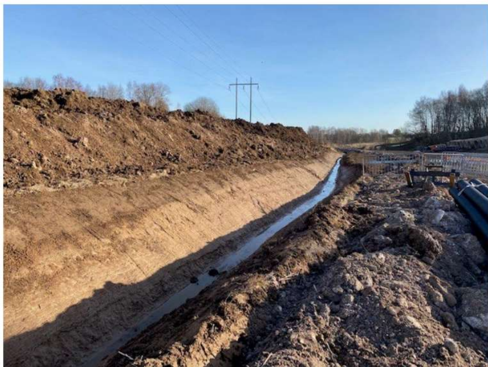
Figur 12. Tillfälligt dagvattensystem på Risatorp, 2023-02-13.
