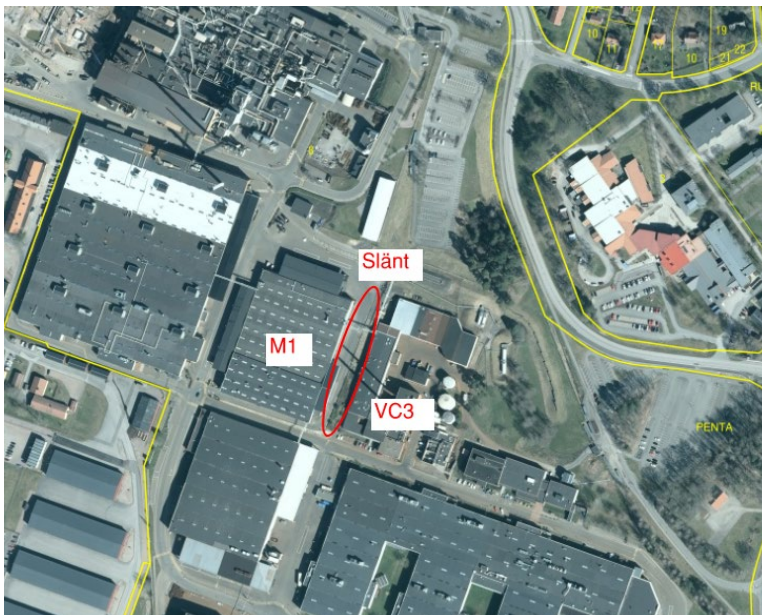
Figur 4. Bilden illustrerar undersökt slänt och intilliggande byggnader (Stjärnberg & Lersten Geoteknik Bilaga D).
