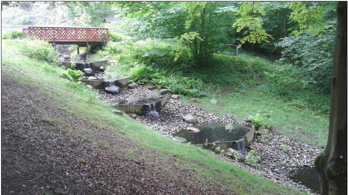
Figur 19. Sektionerat dike med överfall, Slottsskogen i Göteborg (Foto: Norconsult).
