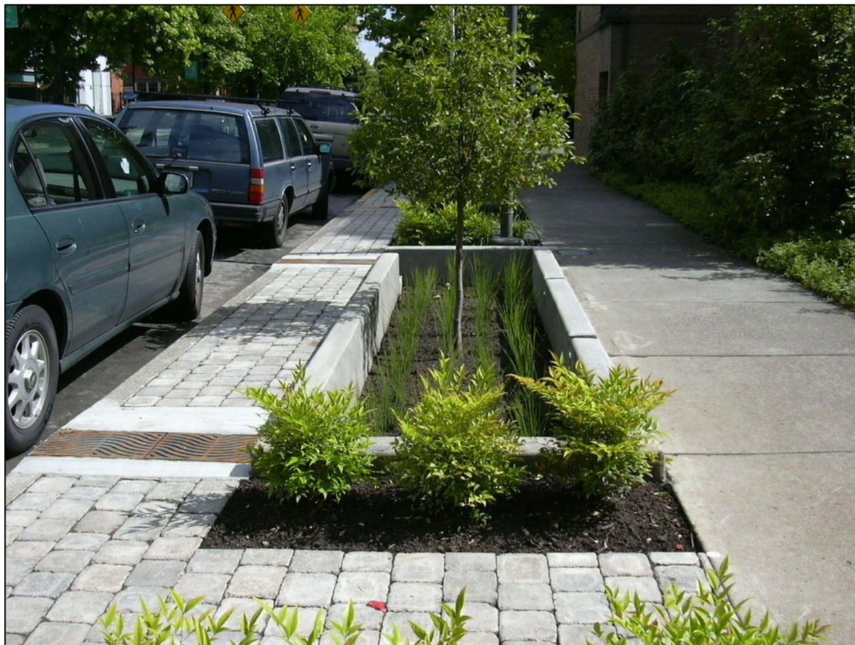
Figur 14. Illustration av en nyanlagd regnrabatt i kombination med genomsläpplig beläggning (City of Portland, 2018).
