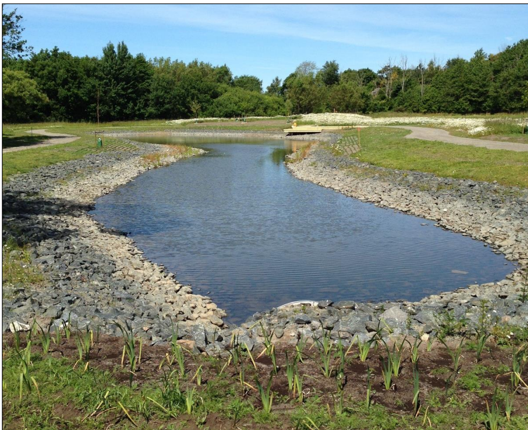
Figur 13. Exempel på dagvattendamm i Trönninge i Varberg. (Foto: Norconsult)
