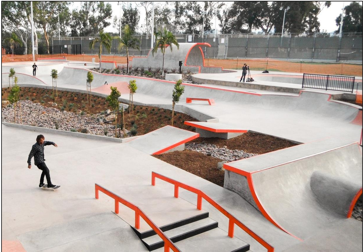
Figur 21. Dagvattenhantering integrerad i en skateboardpark. Multifunktionell översvämningssyta (BWE, 2018).
