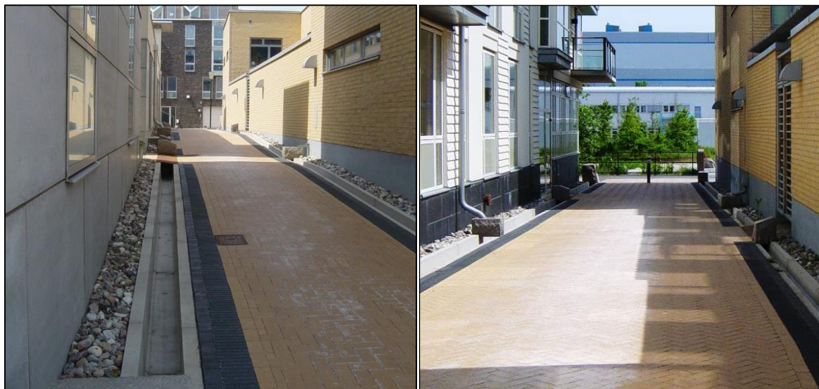
Figur 6. Exempel på rännor och linjeavvattning längs med byggnader i Malmö (Foto: Norconsult).
