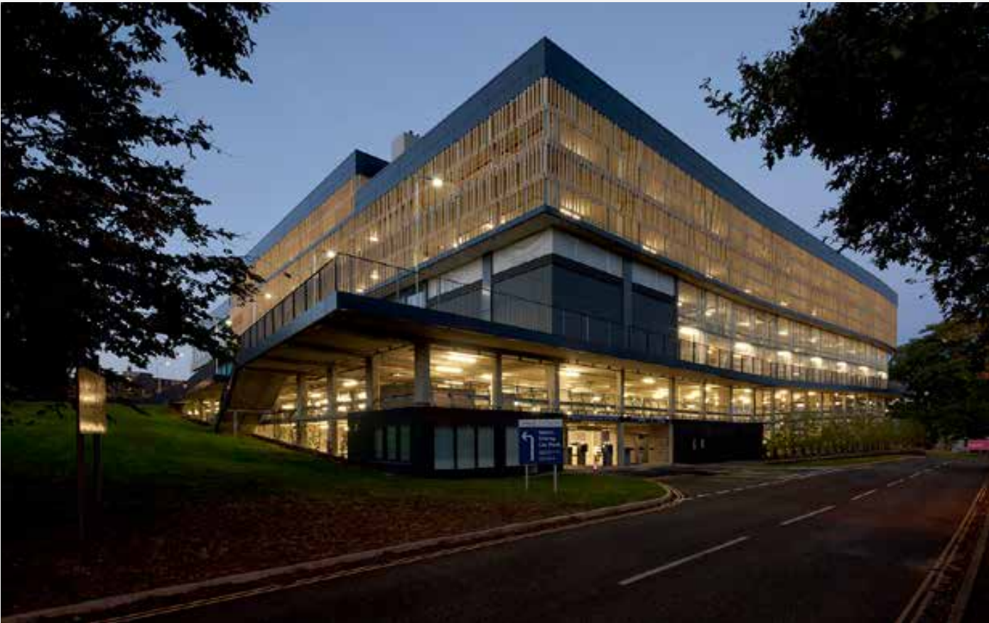
Bircham Park Multi Storey Car Park - Parkeringshus med kontor och handel
