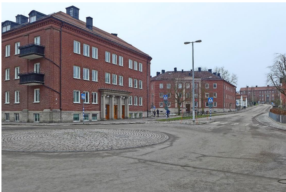
Vy längs Skolgatan med läroverket vid Vårfruplatsen i fonden, 2025-01-20. Bebyggelsen präglas av stora byggnadsvolymer med röda tegelfasader Foto: Ulf Larsson.
