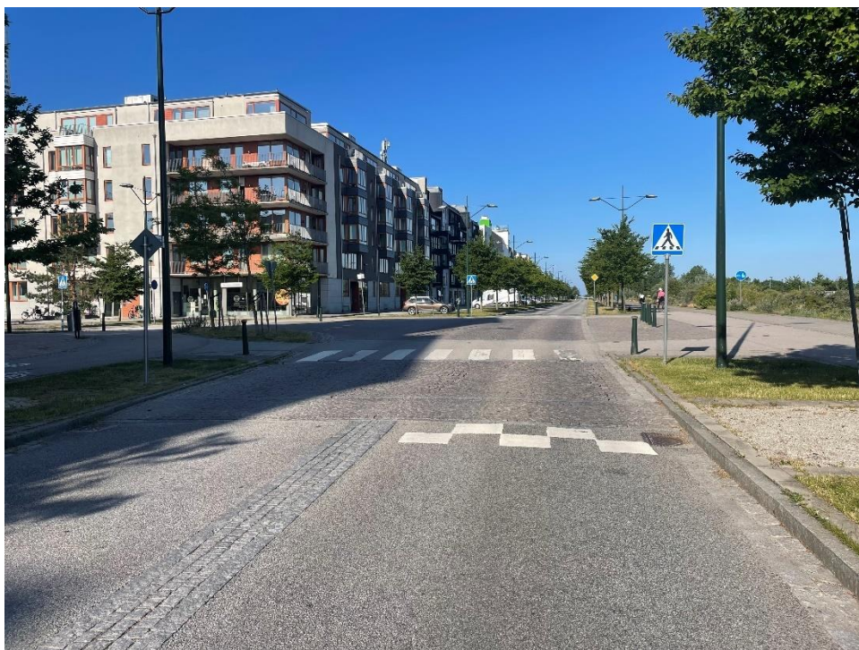
Figur 33. Upphöjd korsning med övergångsställe och cykelpassage Västra Hamnen Malmö. Foto: Ramboll
