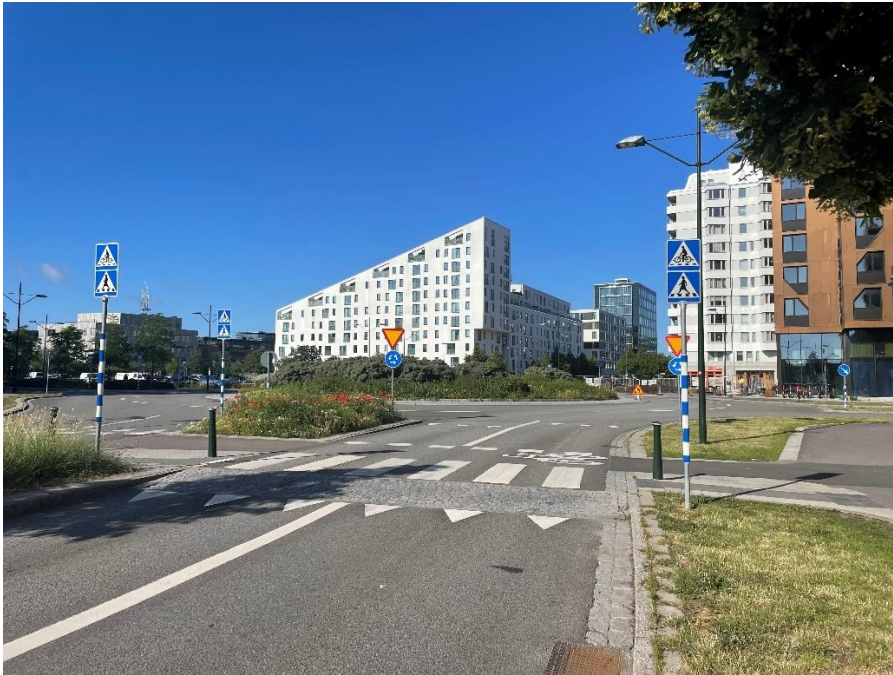
Figur 30. Cirkulationsplats med ramper, Västra hamnen Malmö. Foto: Ramboll
