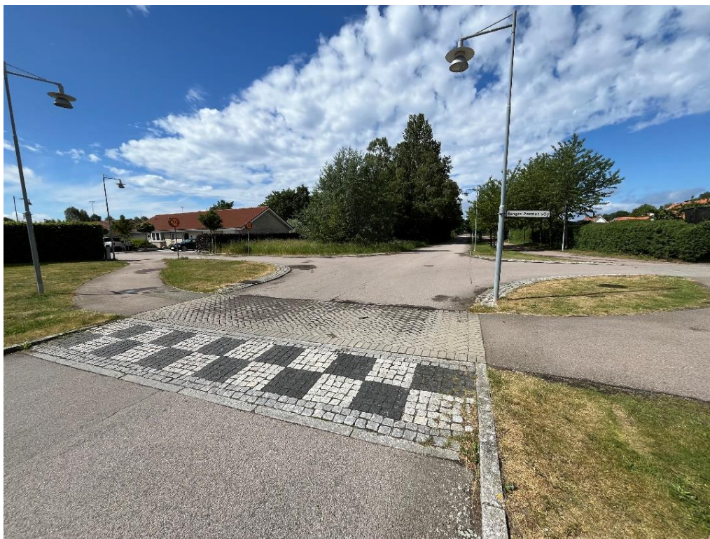
Figur 34. Upphöjd korsning i Bjärred med passage. Foto: Ramboll.
