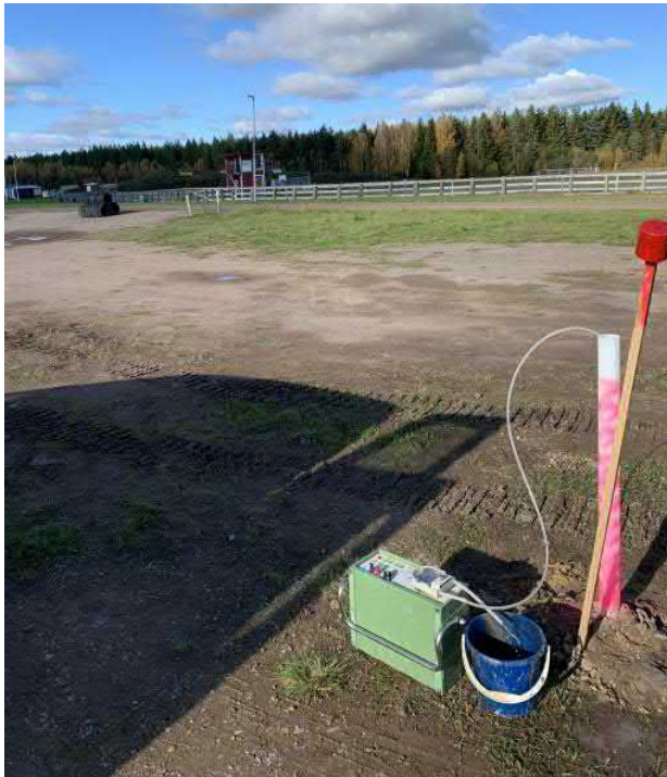
Figur 7. Grundvattenrör i punkt 21TY025. Punkten är belägen centralt inne på Skövdes motorklubb. Renspumpning 2021-10-12.
