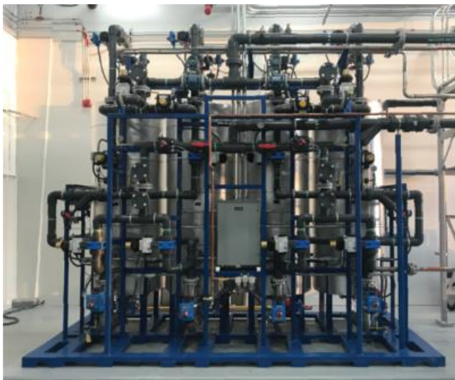
Figur 12. Regenereringssystem på Pease flygbas, New Hampshire USA.
