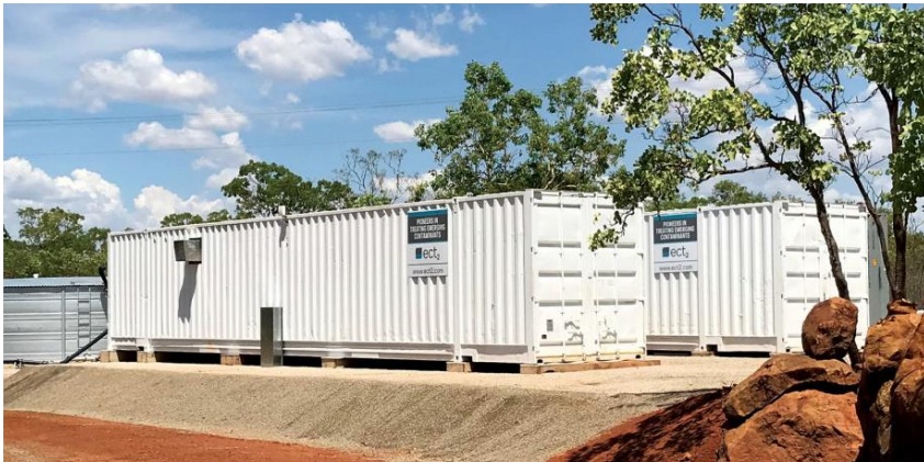
Figur 9. 13 l/s dricksvattenreningsystem i Katherine, Australien.
