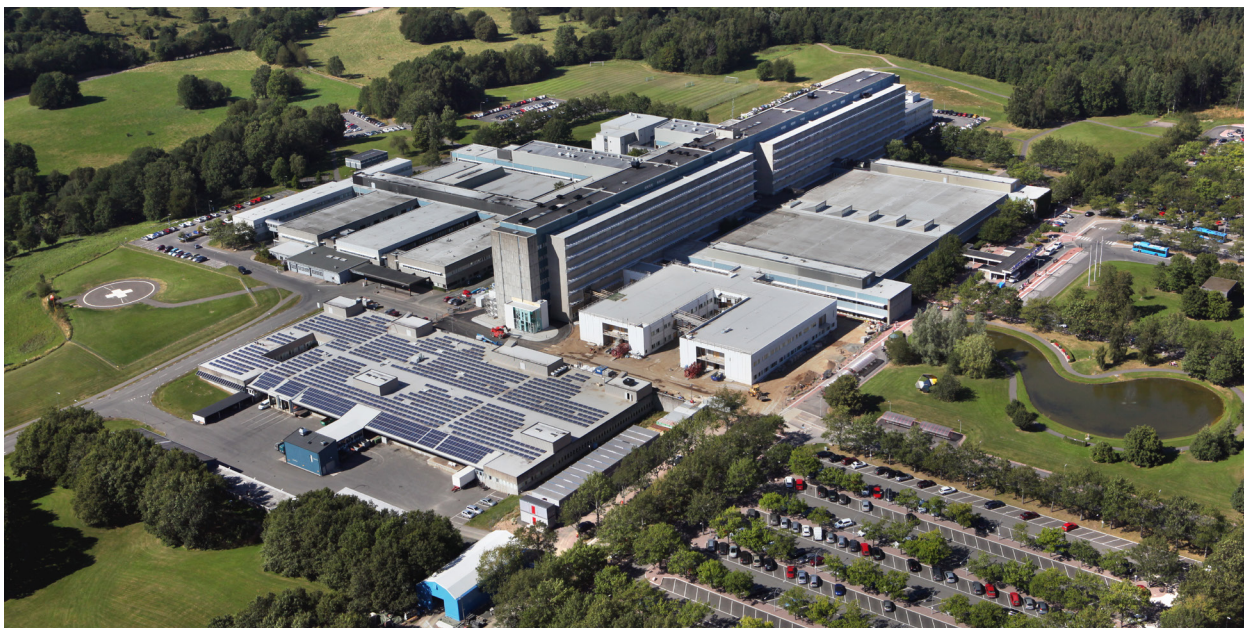
Skaraborgs Sjukhus Skövde. Bildkälla: Västfastigheter.
