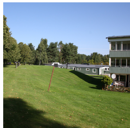
Ett av skyddsrummen norr om planområdet.
